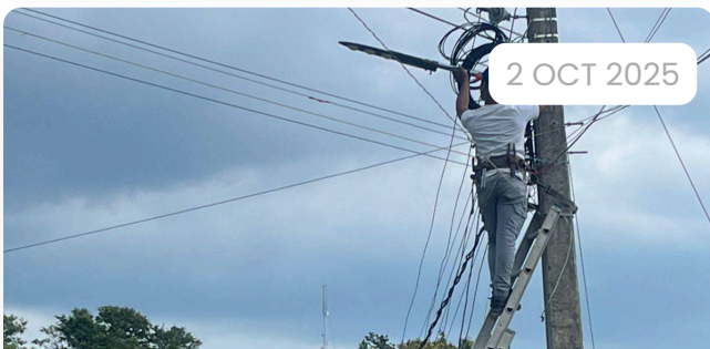
Trabajos de mantenimiento en las líneas eléctricas de Juncalito...
