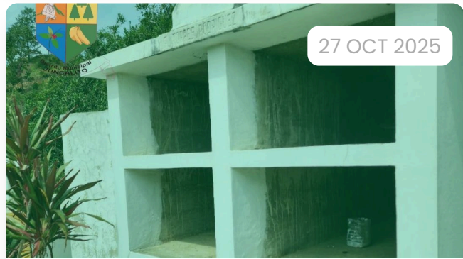
Inician construcción de nuevos nichos y remodelación del...
